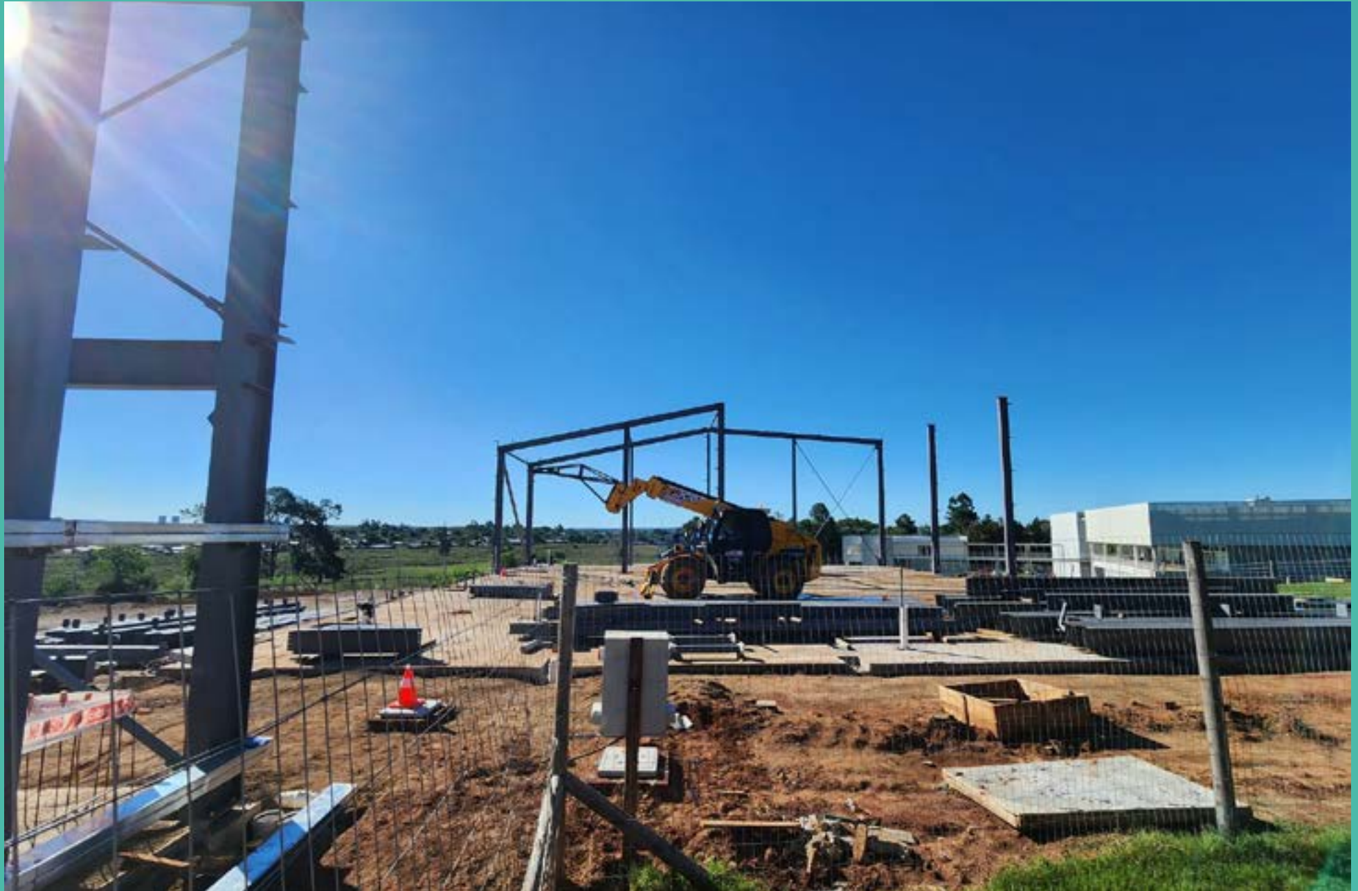
Foto: Gimnasio en construcción, Centro Universitario Rivera (CUR), 2024 - Unidad de Comunicación del ISEF
